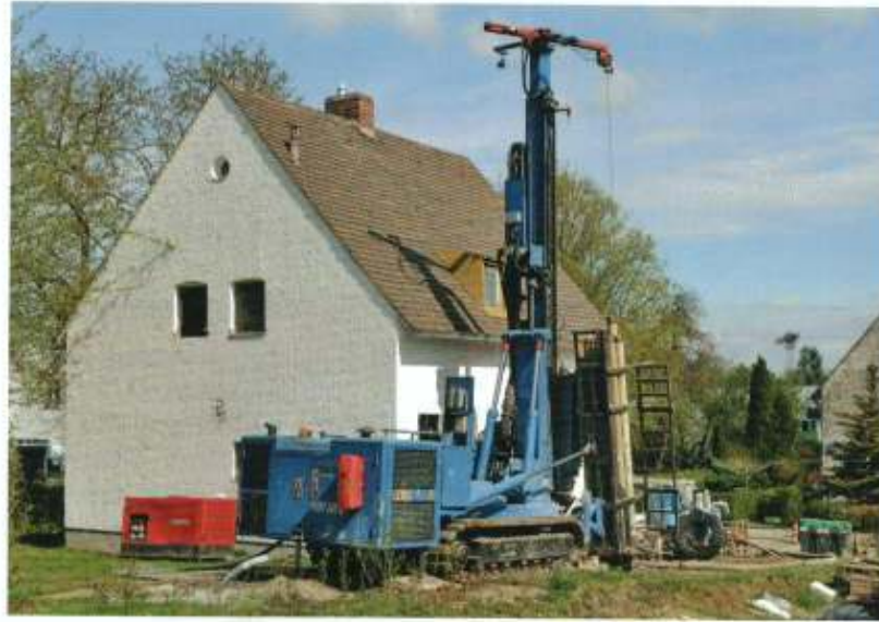
Schweres Gerät: Bohrungen zur Installation einer Erdsonden-Wärmepumpe sind nicht nur sehr aufwendig und erfordern zahlreiche Genehmigungen. Sie sind zudem teuer.
