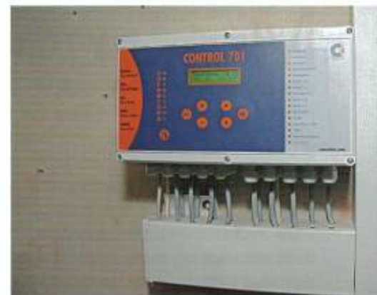
Eine Öl-Brennwert-Solarheizung senkte im Verbund mit Wärmedämmung den Primärenergiebedarf um 72 Prozent.
